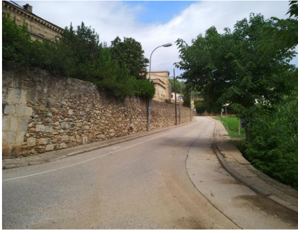
Paviment en bon estat al Carrer Sant Daniel (pas riu Galligants)
