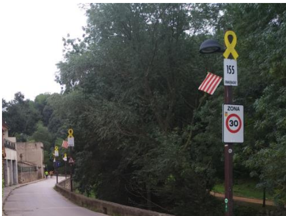
Il·luminació existent al carrer de Sant Daniel
