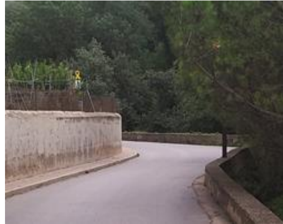
Paviment en bon estat al Carrer Sant Daniel, 4
