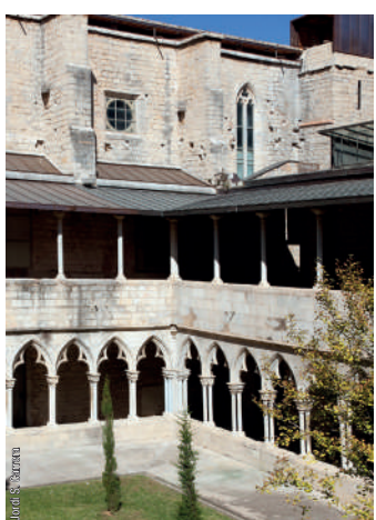
El convent de Sant Domènec (s. XIII-XIV), un dels primers edificis gòtics de Catalunya, té els seus elements principals en l'església, l'aula capítular i el claustre gran. De l'edifici de les Àlguies se'n conserva només la façana (s. XVI), exemple rar a la ciutat d'arquitectura renaixentista.
