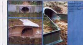
Passos d'amfibis consistents en tanques conductores i tubs que permeten el desplaçament dels animals en ambdós sentits. (1)
