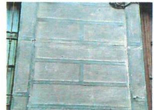
Parament amb imitació de carreus de pedra amb tècnica d'estuc.
