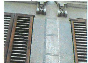
Parament amb imitació de carreus de pedra amb tècnica de pintura.
