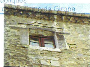
Coronament amb absència de goltes i format per doblat de rajola i tortugada.
