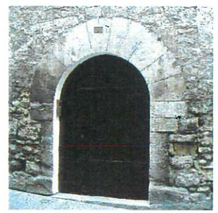
Planta baixa de pedra i portal amb arc adovellat.
