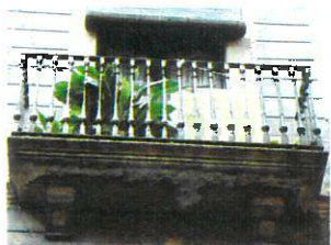
Balcó de pedra motllurada recolzat en mènsules i amb baranes amb brèndoles de fosa.
