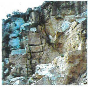
Pedreres "Anglada" i "Solés". Els materials constructius locals marquen les pautes del cromatisme urbà.
