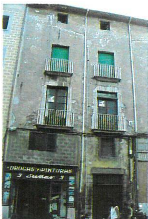
C. Pujada Pont de Pedra 3
