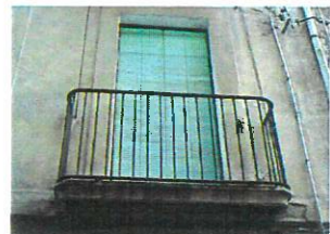
Baranes simples de barrots rectes amb aparició de llosanes en punt rodó.
