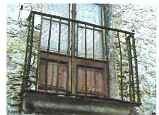
Barana forjada de perfil quadrat amb barrots el·liçoidals als extrems.
