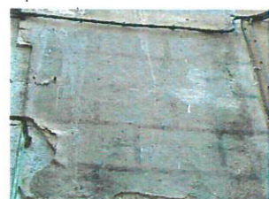
Aparició d'arrebossats marcant filets per a imitar carreus de pedra.
