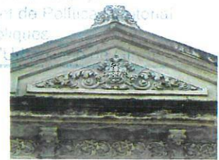
Ornamentació eclèctica amb cornisa volada.
