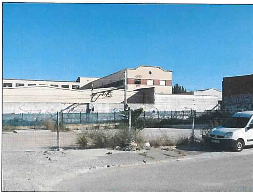
Foto 8. PAU-117. Naus abandonades des de ponent. Perspectiva des del carrer Alacant.
