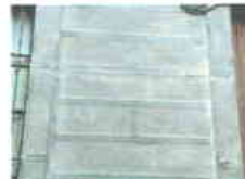
Parament amb imitació de carreus de pedra amb tècnica d'estuc
