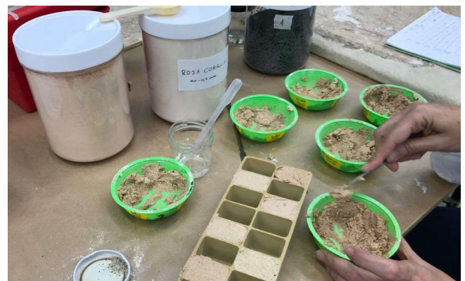
Fig.3.- Preparando de una base de mortero para reintegrar una pintura mural. (Autor: Joan Pifarré)
