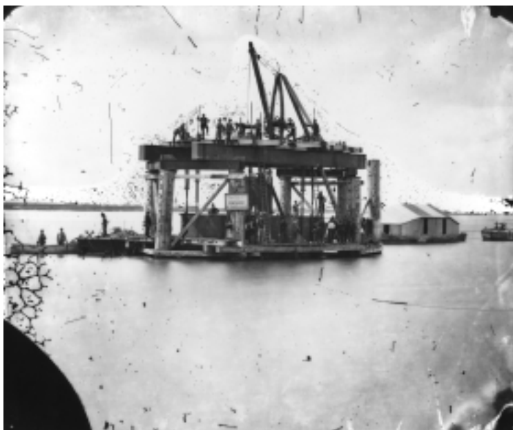
Construcció del pont Lim Fjord el 1877 per part de l'empresa francesa Compagnie de Fives-Lille amb l'ús d'enginyers francesos i treballadors italians. El fotògraf d'Aalborg Henrich Tønnes es va dedicar a documentar les feines de construcció. Negatiu sobre vidre de 31 x 36,7 cm. (Foto: Arxiu Municipal d'Aalborg.)
