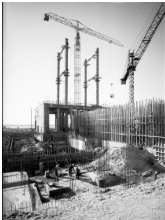
Mitjançant la seva producció, Julius Brems va documentar l'arribada de l'estat del benestar a partir de la dècada de 1950 a Aalborg. També va participar en la documentació de les feines de construcció del túnel sota el pont Lim Fjord a finals de la dècada de 1960. (Foto: Arxiu Municipal d'Aalborg.)
