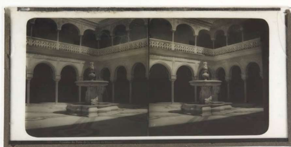
Figura 36. Montaje con vidrio protector translúcido (anverso). La imagen se observa a través del vidrio de soporte | CIAF0025.
