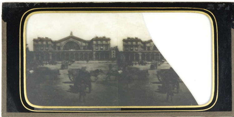
Figura 38. Fractura con pérdida en el vidrio de soporte | CIAF0039.
