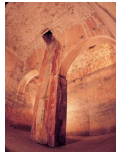
Cisterna del convent de Sant Antoni de frares caputxins, actual MHG. Fotografia de Jordi S. Carrera (2003)
