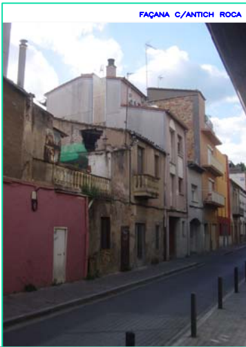
FAÇANA C/ANTICH ROCA
