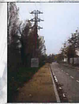
Itinerari existent c/ Port Lligat que marca els criteris d'urbanització per a completar l'itinerari 3
