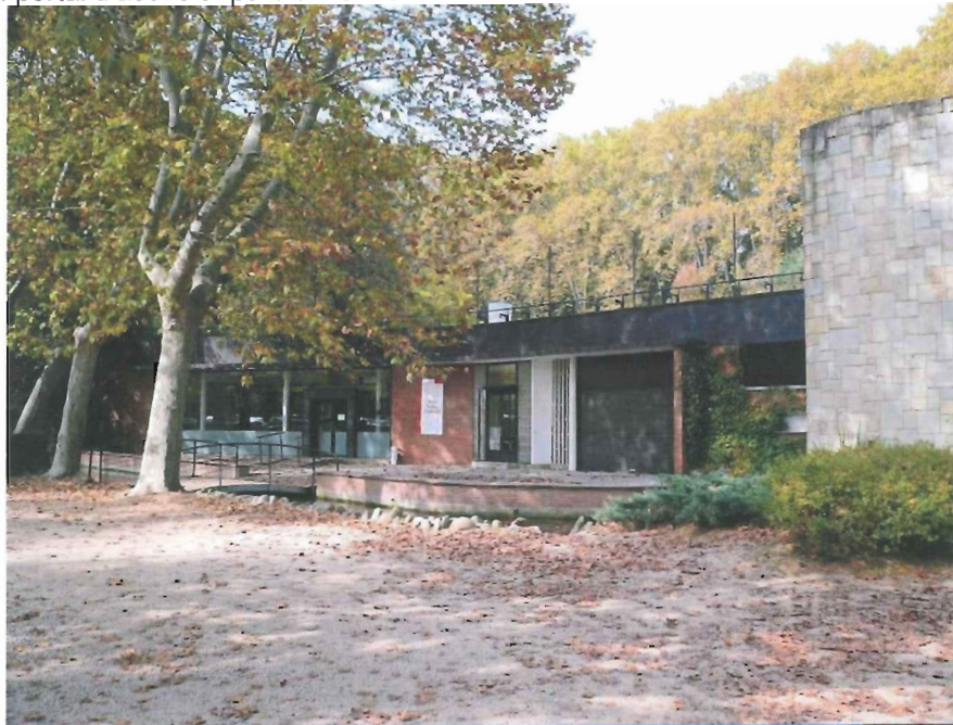
Imatge del portal d'accés al parc de la Devesa
