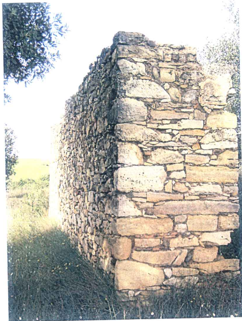
Fotos murs de pedra
