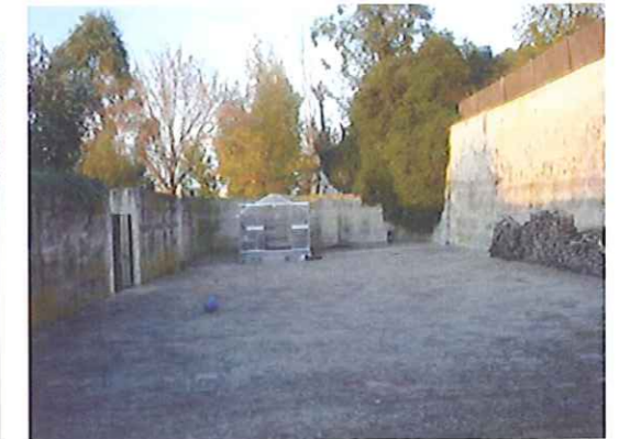
INTERIOR MIRANT CAP AL NORD
