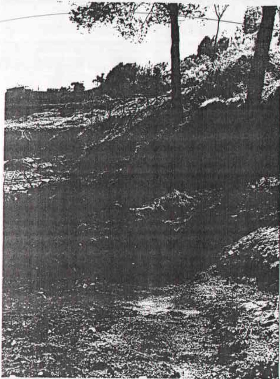
Esllavissada d'un talús d'argila d'haver modificat l'equilibri uns mesos abans. - (Camí de la font d'en Pericot a les - Crous).
