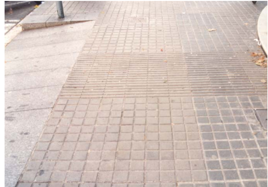
Paviment diferenciat per a persones cegues junt a pas de vianants.
